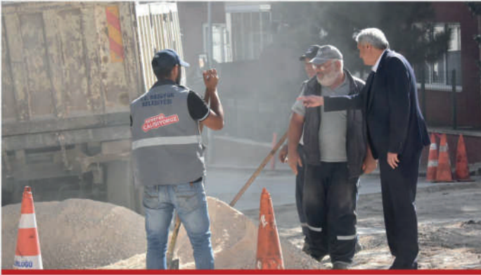
Bozüyük Belediye Başkanımız Mehmet Talat Bakkalçioğlu, Yeni Mahalle'de devam eden sıcak asfalt çalışmalarına katılarak çalışmaları yerinde inceledi.
